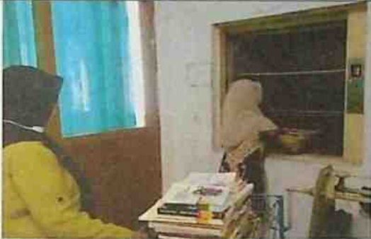
Dokumentasi 3. Lift Pengantaran Buku
